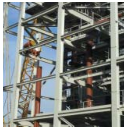
Montáž potrubí v ocelové konstrukci
