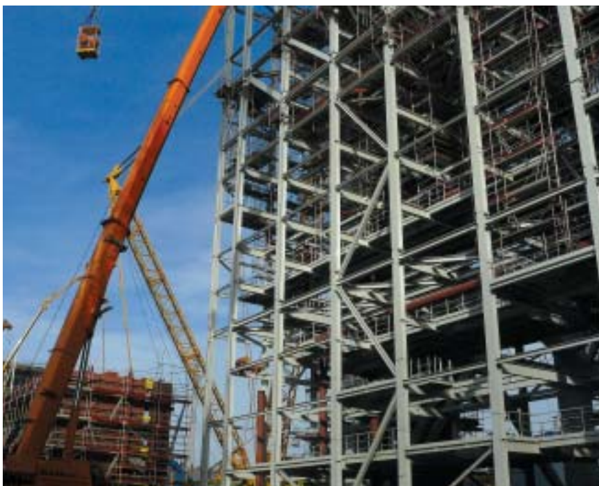
Snímek z montáže ocelové konstrukce kotle
